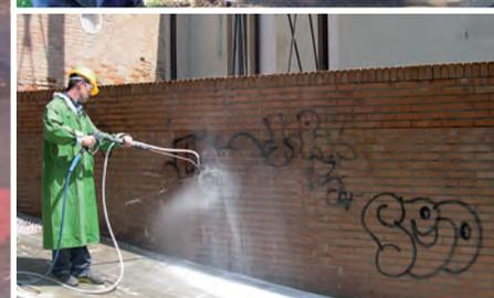
**ECR-Eco Remover** è una macchina di IPC Portotecnica che aggiunge alle tradizionali funzioni di un'idropulitrice, un sistema integrato per la rimozione dei graffiti tramite l'utilizzo di inerti derivati del bicarbonato. ECR è ecologico e sicuro, pratico e facile da utilizzare anche da operatori non specializzati.
